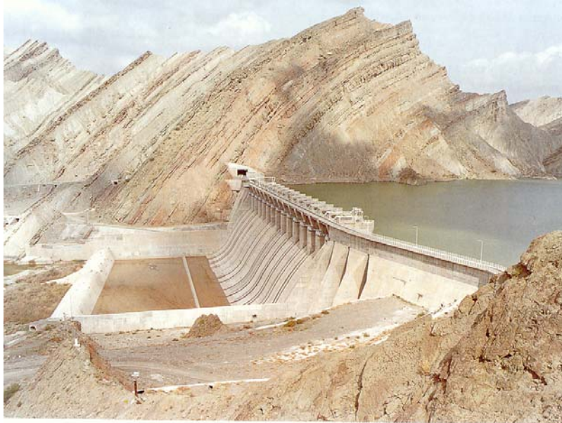
نمای یک سد بتنی
