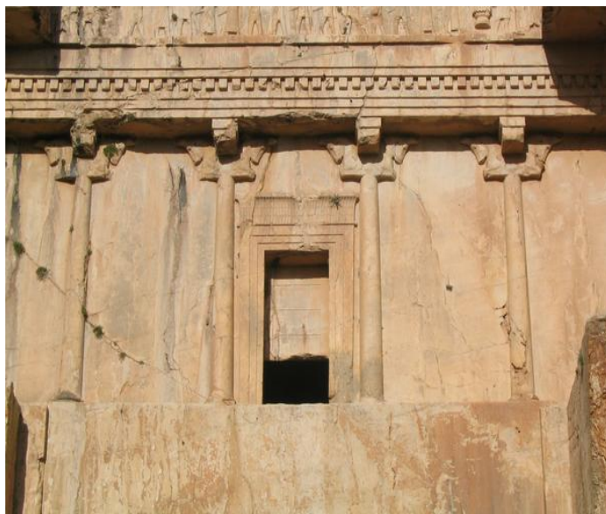
شکل ۲۲- در ورودی و ستون‌های آرامگاه هخامنشی
