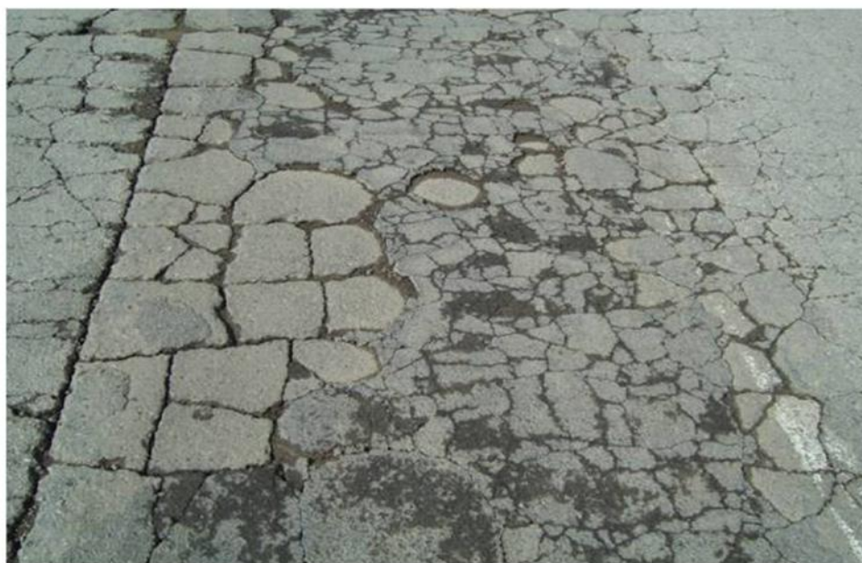
شکل ۱ نمونه‌ای از ترکهای موزاییکی.
