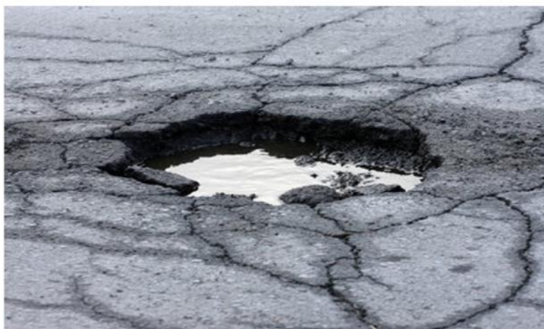
شکل ۶ نمونه‌ای از چاله در روسازی آسفالتی.
