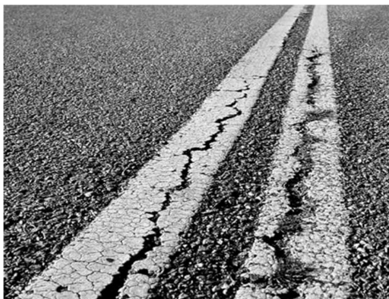
شکل ۲ نمونه‌ای از ترکهای برشی.
