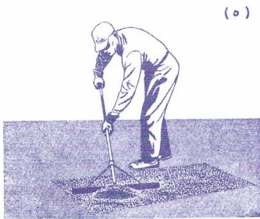
شکل ۲ مراحل اصولی وصله سطحی روسازیهای آسفالتی.
