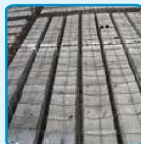
شکل ۲-۲۸- سقف تیرچه و بلوک
