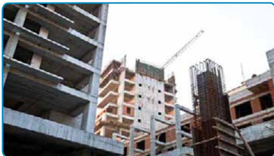
شکل ۱-۲- سازه‌های بتن آرمه
