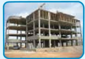
شکل ۲-۲- سازه های بتنی
