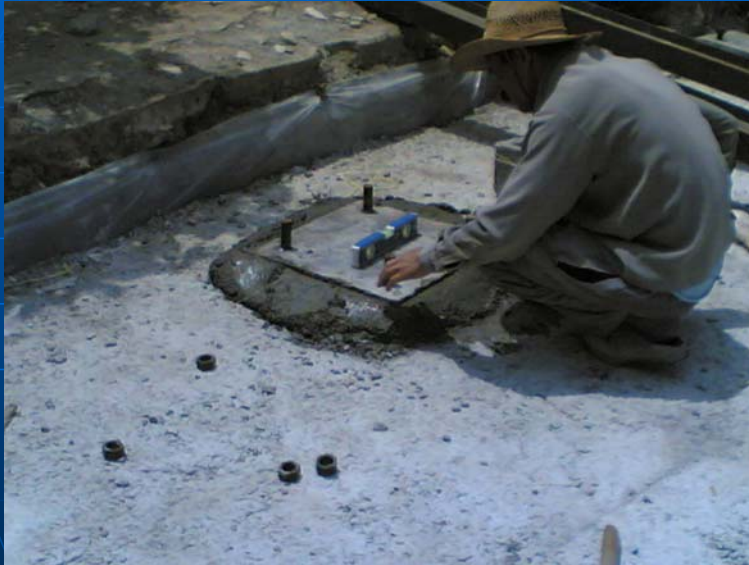
رگلاژ نهائی کف ستون
