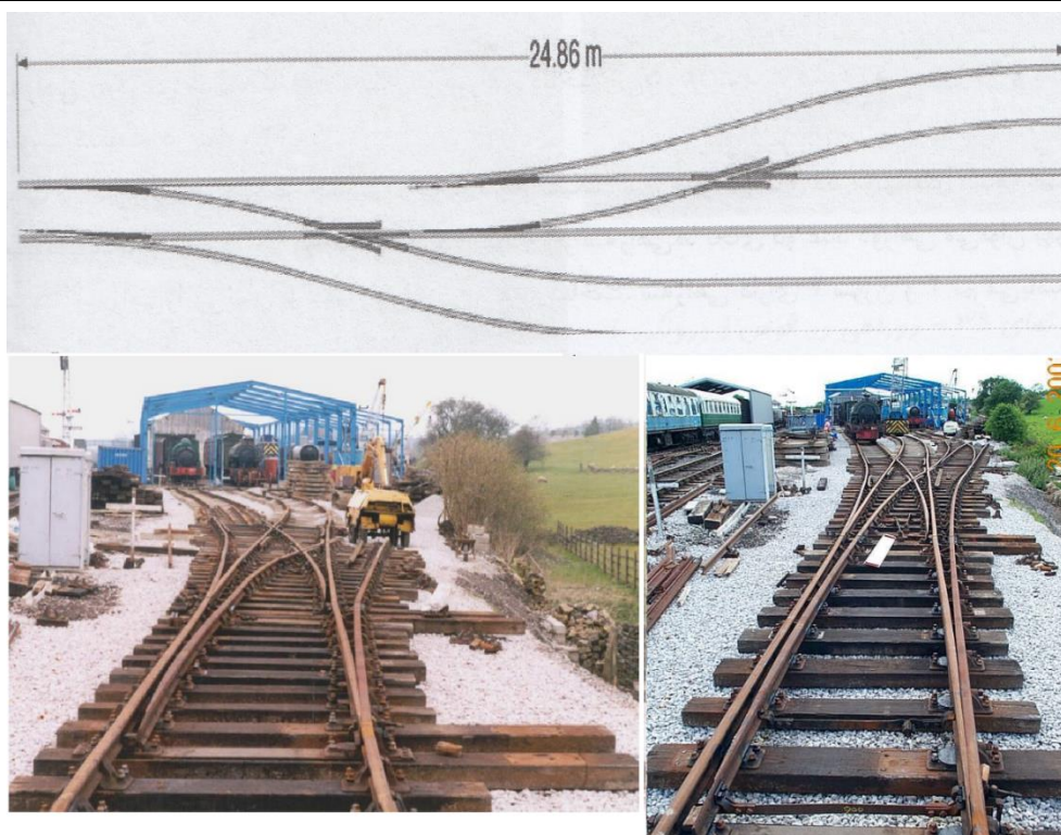
شکل (۷-۸) سه راهی فشرده و شکافته
