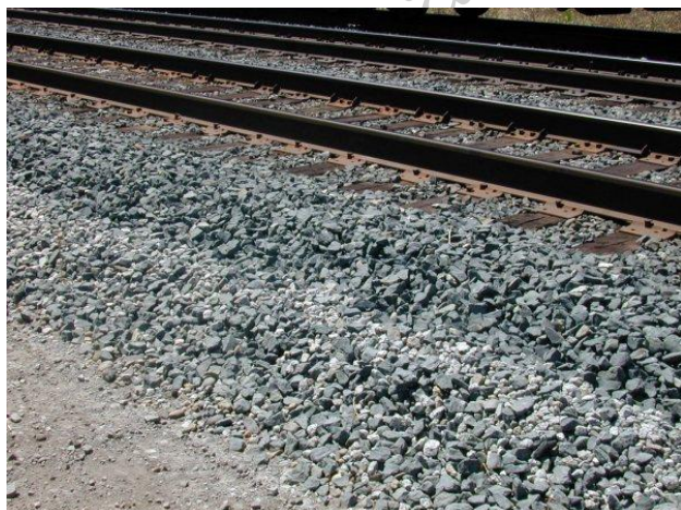
شکل (۵-۱) نمایش لایه بالاست در خط راه آهن
