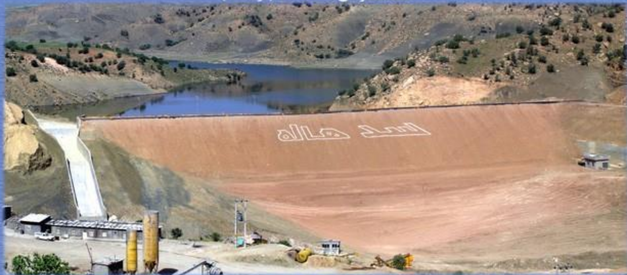
پیمانکار: شرکت ساختمانی سازوز تهران
