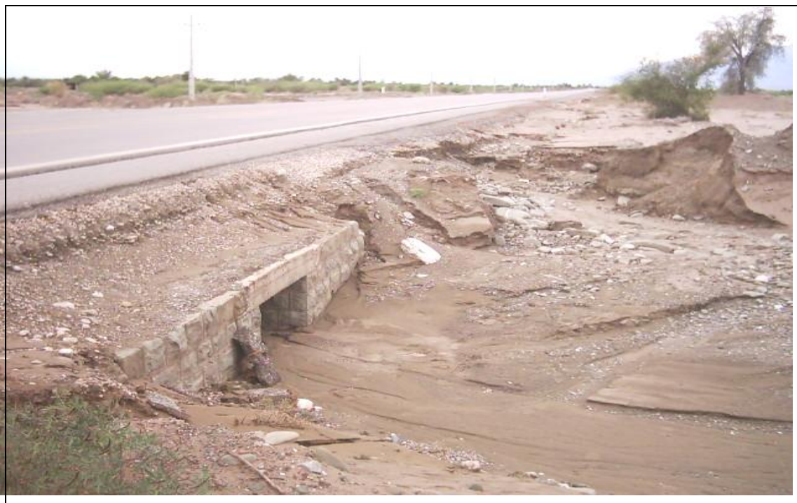
شکل 7-1- پر شدن دهانه آبرو از رسوبات
