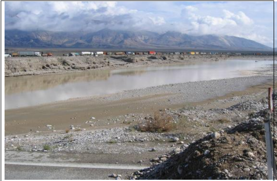
شکل 1-11- ترافیک بوجود آمده در محل پل قبل از احداث کنارگذر
