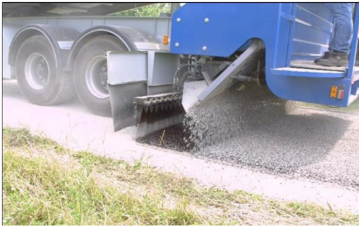
شکل (۶-۶): اجرای یک لایه قیر به همراه پخش یک لایه ماسه روی آن
