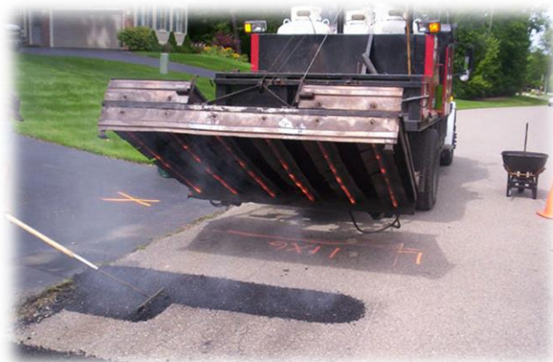
شکل (۷-۹) گرم کردن سطح آسفالت با سامانه گرمایشی مادون قرمز
