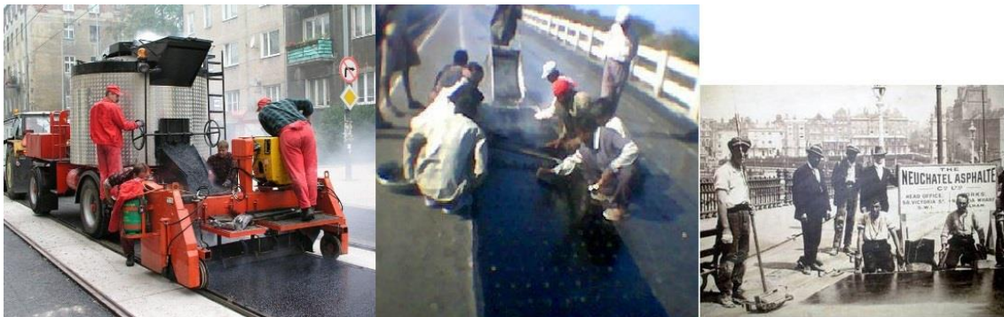
شکل (۶-۱): اجرای دستی و مکانیزه آسفالت ماستیک
