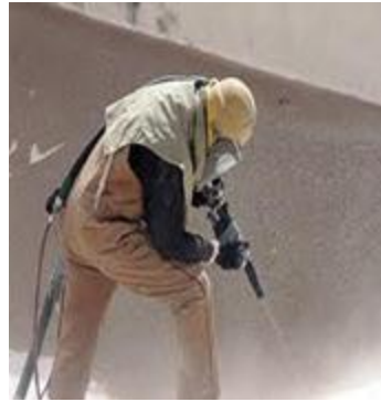
تصویر شماره ۵۱: عملیات سندبلاستینگ
