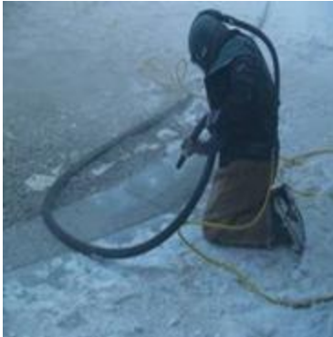
تصویر شماره ۵۱: عملیات سندبلاستینگ
