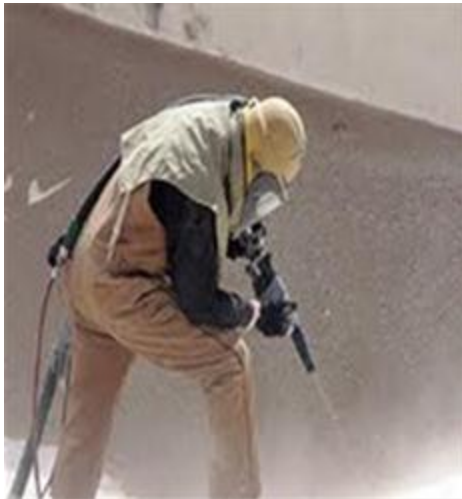
تصویر شماره ۱۶: تصاویر عملیات سندبلاستینگ
