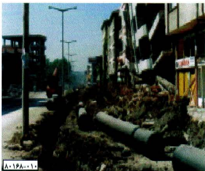
شکل ۱-۱۰: کارگذاری خط لوله فاضلاب پس از وقوع زلزله که به دلیل وارد شدن خسارات جدی به خط لوله و تخریب کلی آن انجام شده است. B
