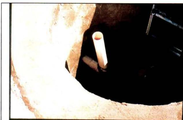
۴- ورودی باید طوری باشد که اختلاط در تانک حداقل باشد. برای این کار استفاده از یک سه راهی با قطر بیش از ۱۰۰ میلی متر توصیه می شود.
