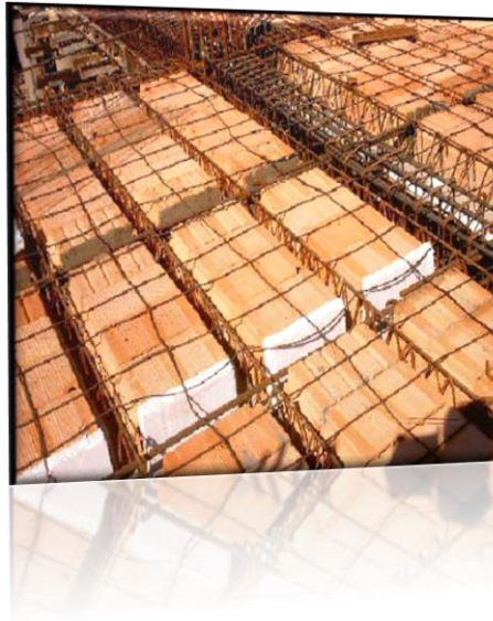
پر کردن سوراخهای بلوکها برای جلوگیری از نفوذ بتن به داخل آنها
