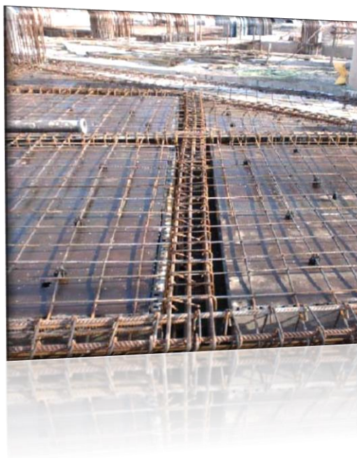
فاصله منظم شبکه آرماتوری - استفاده از اسپیسر برای تنظیم فاصله پوشش بتن بر روی آرماتور
