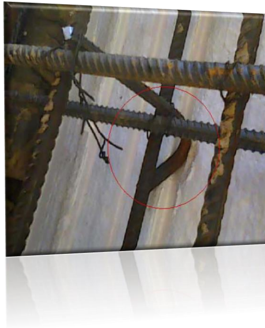
استفاده از سنجاقک نامناسب و تکیه کردن سنجاقک به دیوار
