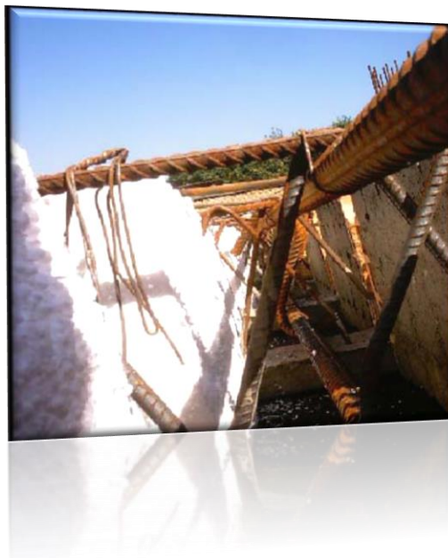
استفاده از میلگرد S شکل برای حفظ فاصله ژوان
