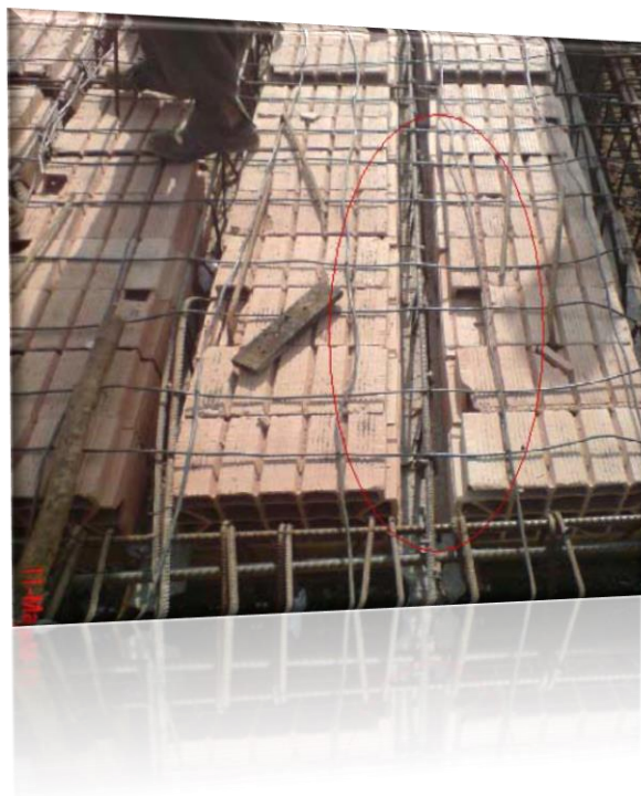
پر نکردن سوراخهای بلوکها و نفوذ بتن به داخل آنها
