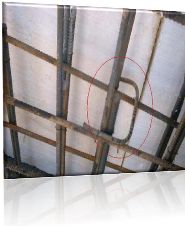
عدم قرارگیری سنجاقک در محل مناسب
