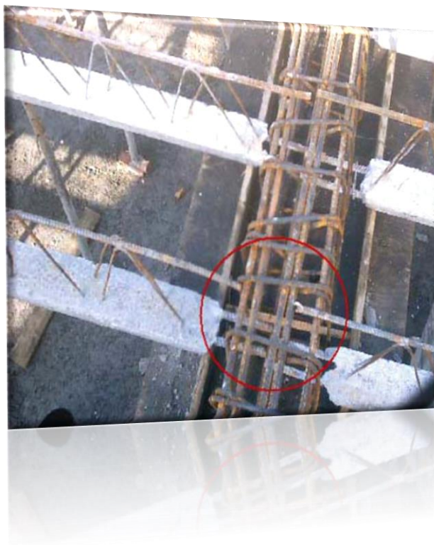
رعایت نکردن طول کافی میلگرد بالایی تیرچه
