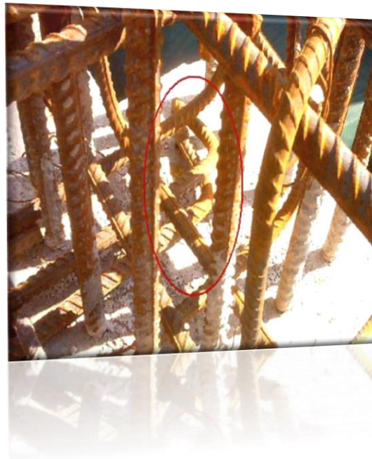
خم شدن میلگرد های پایین تیر و از بین رفتن طول مهاري با بتن
