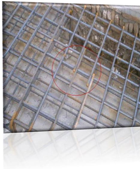
رعایت نکردن اورلپ کافی در شبکه آرماتوری پی و بریدن ميلگرد
