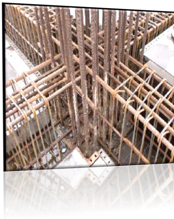
فاصله منظم خاموتها و آرماتورها به کمک استفاده از اسپیسر
