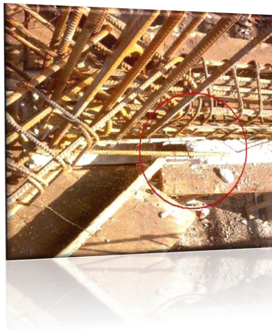
استفاده از وصله (اورلپ) برای تیرچه که باعث ضعف تیرچه در آن محل میشود
