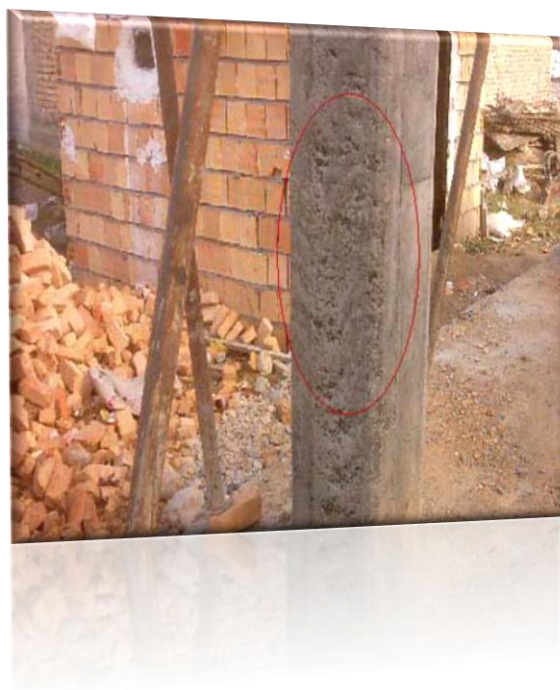
پر نکردن سوراخهای بلوکها و نفوذ بتن به داخل آنها
