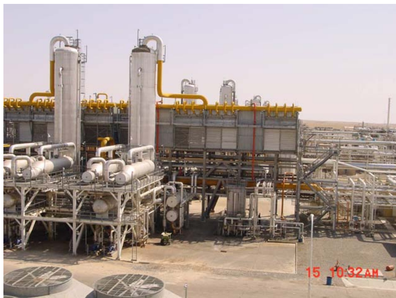
شکل ۸-۱۰: سیستم احیاء آمین
