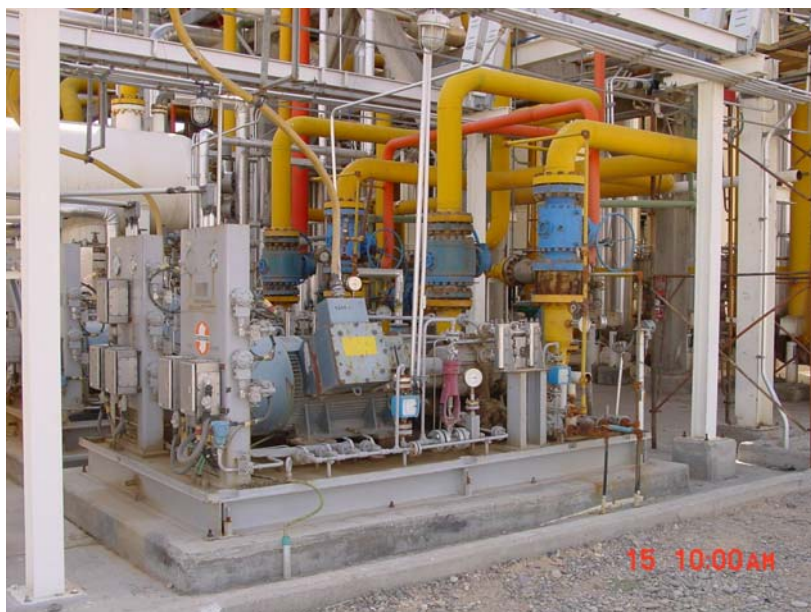
شکل ۸-۹: کمپرسور گاز احیا
