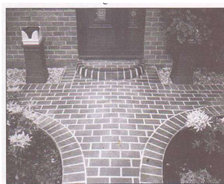
شکل ۳-۷: استفاده از مصالح مشابه بدنه ساختمان در کف سازی (م ۹)
