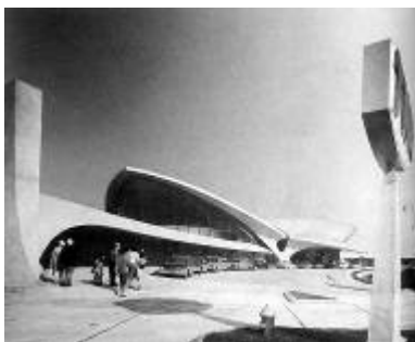
فرودگاه T.W.A، نیویورک
