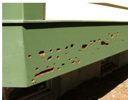
شکل ۴-۱۱: زنبورنجر و نحوه خسارت آن به چوب.
