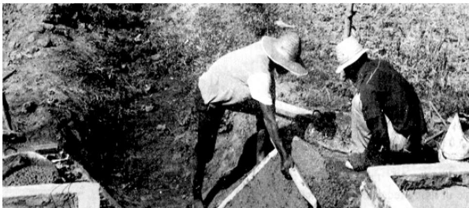
شکل ۴۱. پوشش کانال با اندودکاری دستی
