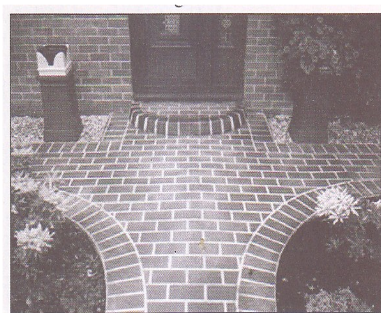
شکل ۳-۷: استفاده از مصالح مشابه بدنه ساختمان در کف سازی (۹م)
