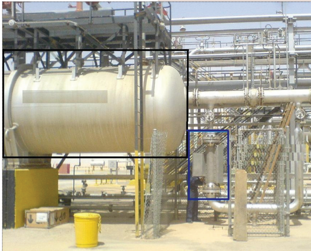
شکل ۵ | مقایسه دستگاه جریان سنج چندفازی با تفکیک‌گر چندفازی
