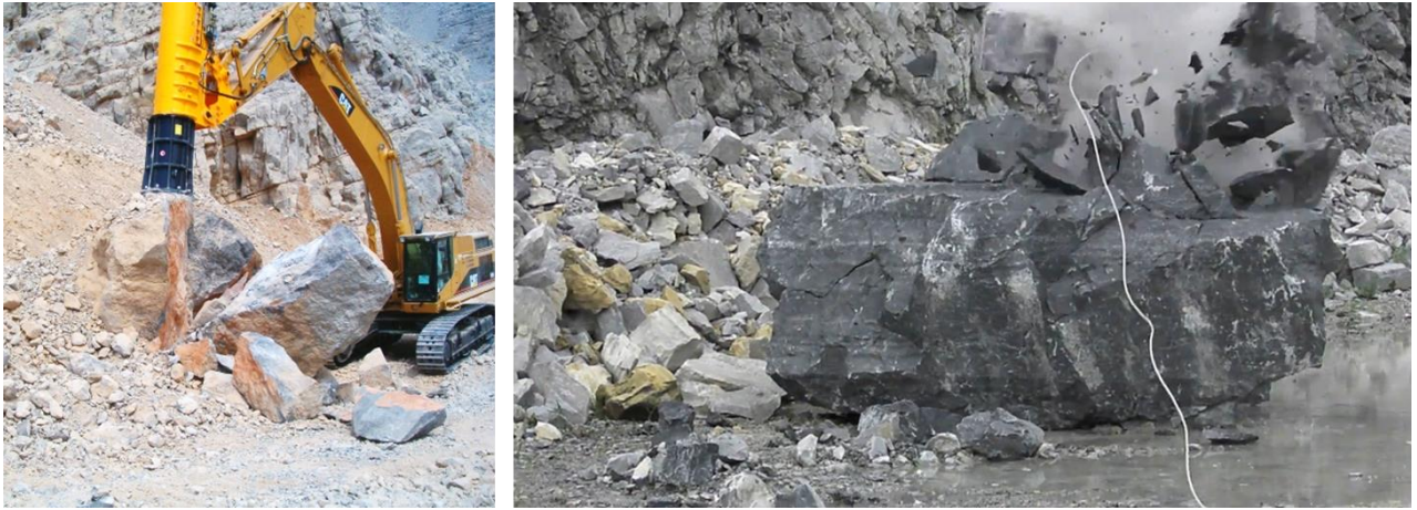
شکل ۱-۱۱: خردایش مجدد روی قطعات بزرگ سنگ باقی مانده از آتشکاری اولیه
