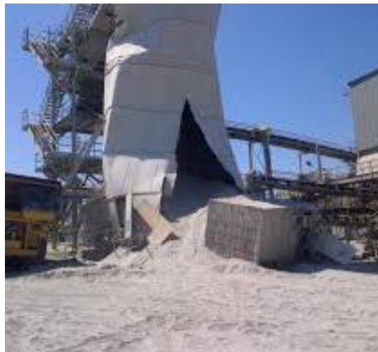
شکل ۴-۲۵: آسیب ناشی از فشار بالای مواد
