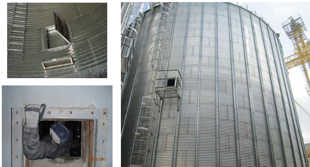
شکل ۴-۴۳: دریچه دسترسی در بدنه مخزن
