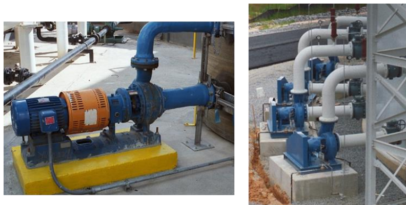
شکل ۳-۲۰: تعلیق توسط گردش مواد با پمپ
