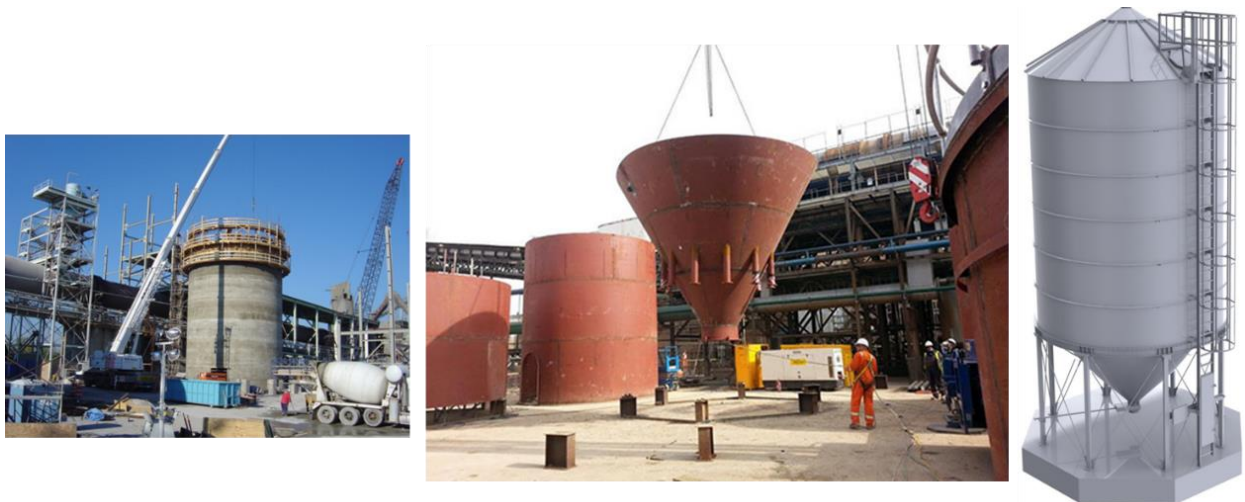
شکل ۴-۵: مراحل ساخت مخازن
