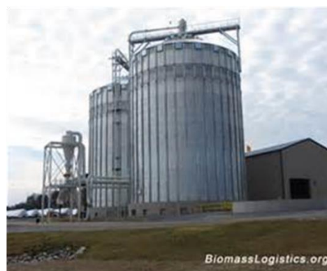
شکل ۳-۱۵: مخازن خوراک دهی با قاعده تخت
