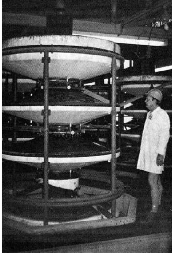
شکل ۳-۳۰- نمونه ای از مخروط جداکننده ریچارد
