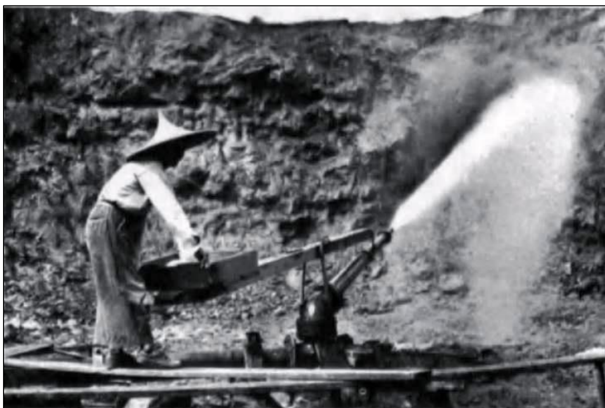
شکل ۳-۲۴- استفاده از فشار آب برای آرایش کانی های حاوی قلع در مالزی
