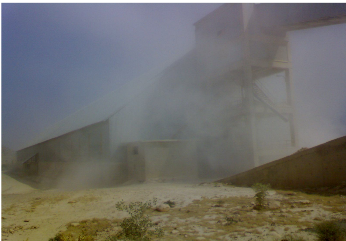
شکل شماره ۱۲ : نمایی از سالن خاک در حال آهک زنی
