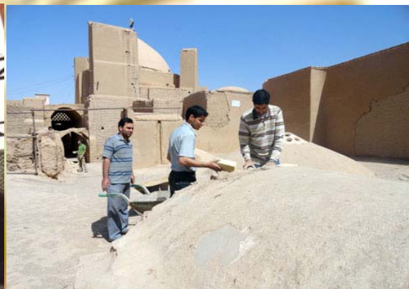
کاهش بار اضافی سقف با برداشتن لایه های اضافی
