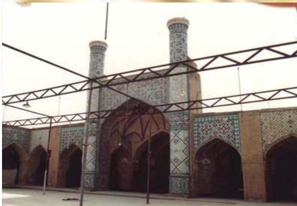
تقویت اجزای عمودی با الحاق اسکلت فلزی - مسجد
