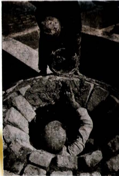
شکل ۱۴۹ - نحوه قفل کردن و بستن تیزه طاق
