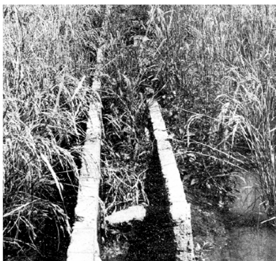
شکل ۳۰. بستر کانال کاملا پوشیده شده است.
