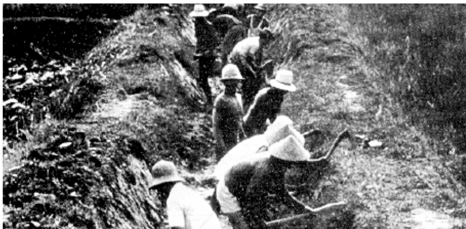
شکل ۳۱. عملیات مربوط به نگهداری کانال‌ها
