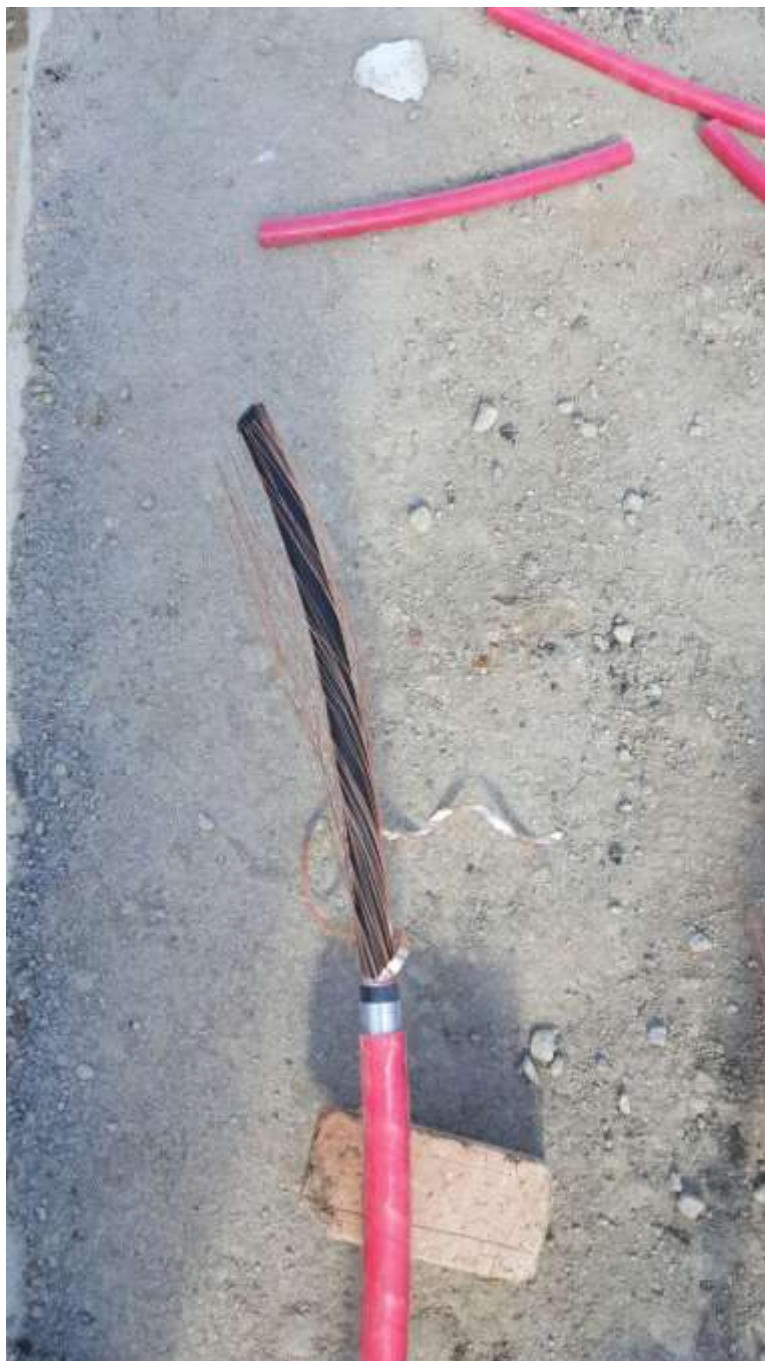
تصویر شمار ۴ شیلد کابل را به سمت پایین کابل میبریم
