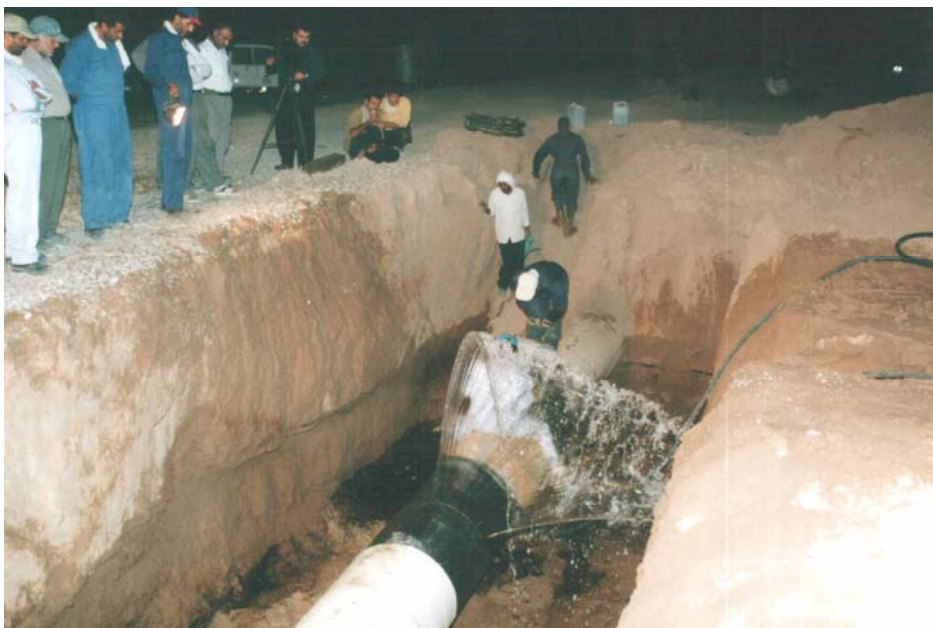
شکل ۳-۵. نمایی از یکی از مراحل تعمیراتی خط لوله اهواز/تنگ فنی
