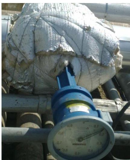
PD meter عایق بندی شده، استفاده شده در یکی از خطوط انتقال پالایشگاه
