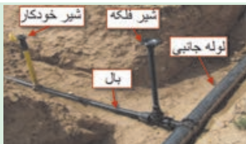
شکل ۱۳-۵. محل شیر فلکه روی بال
