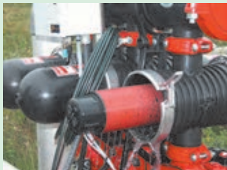
شکل ۶۰-۵. شست و شوی دستی صافی دیسکی
