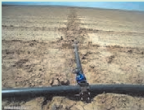
شکل ۴۶-۵. شیر فلکه لوله جانبی
