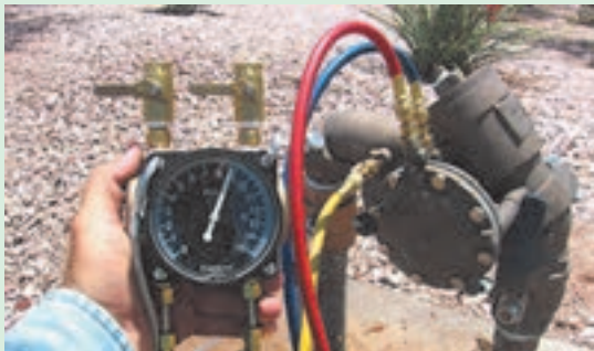
شکل ۳۱-۵. تنظیم فشار شیر فشار شکن
