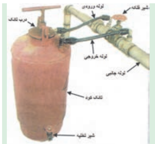
شکل ۴۹-۵. اجزای سیستم توزیع کود
