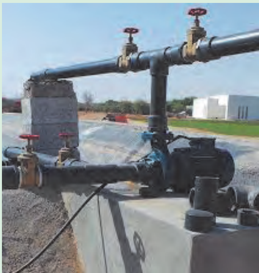
شکل ۱۲-۵. شیر فلکه لوله رانش
