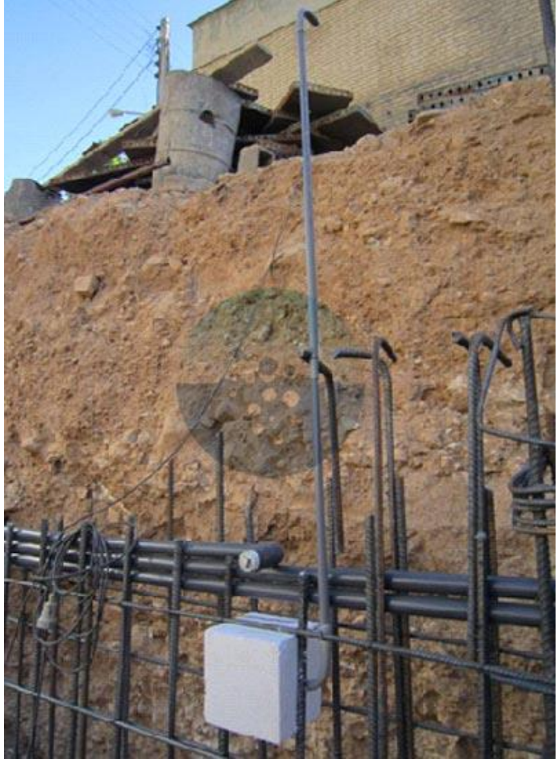
تصویر اجرای فوم جهت نصب کاسه چراغ استخر
