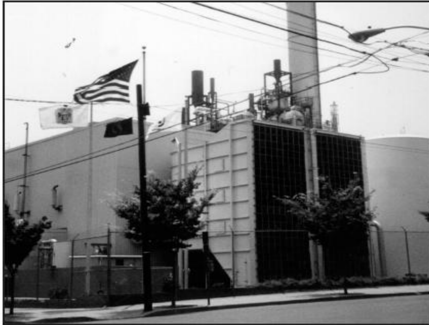
شکل ۵ - اتاق فیلتر دهانه ورودی برای Frame VEA
