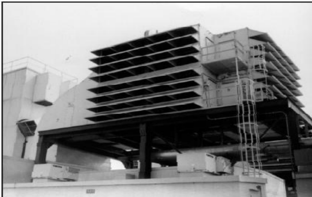
شکل ۵ - اتاق فیلتر دهانه ورودی برای Frame VEA
