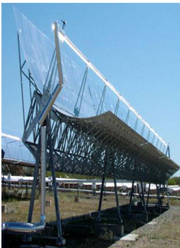
شکل ۱-۲ نیروگاه سهموی خطی ۲۵۰ کیلووات شیراز
