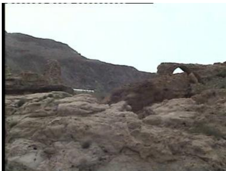
شکل (۶-۱۲) پل چهاردهنه شرف آباد
