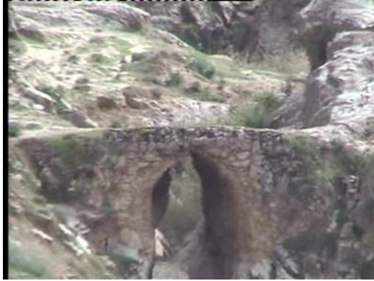
پل یک دهنه شرف آباد
