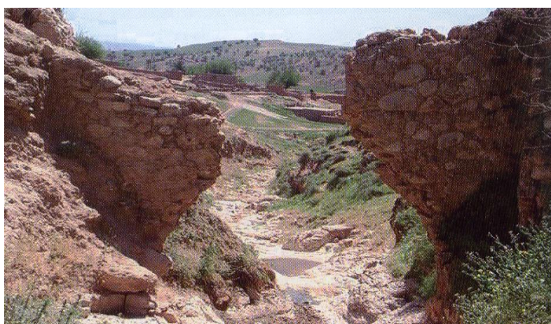
شکل (۶-۹) پل کرودیت
