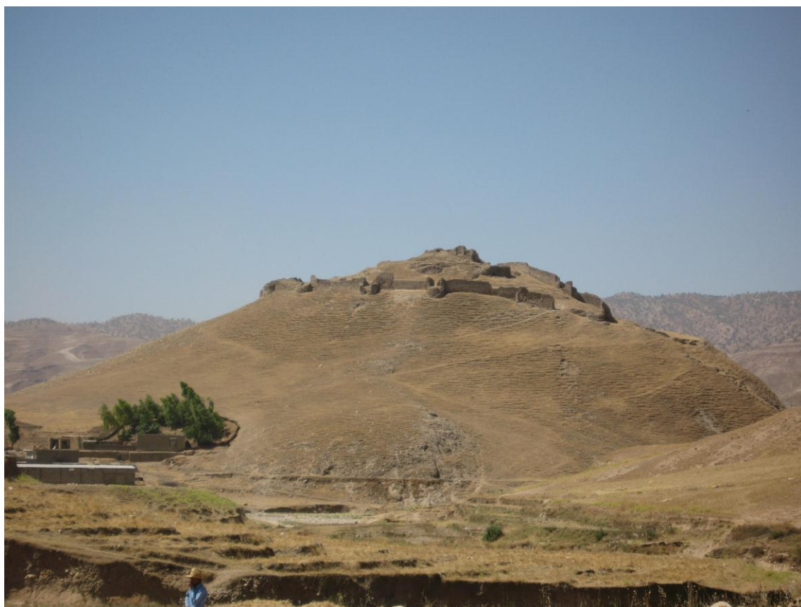
شکل (۶-۶) بخشی از بنای قلعه پشت قلعه آبدانان
