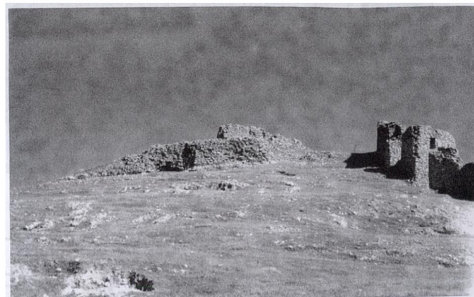
شکل ( ۶-۶) بخشی از بنای قلعه پشت قلعه آبدانان
