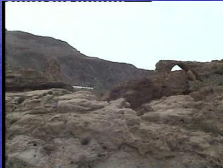
شکل (۶-۱۲) پل چهاردهنه شرف آباد
