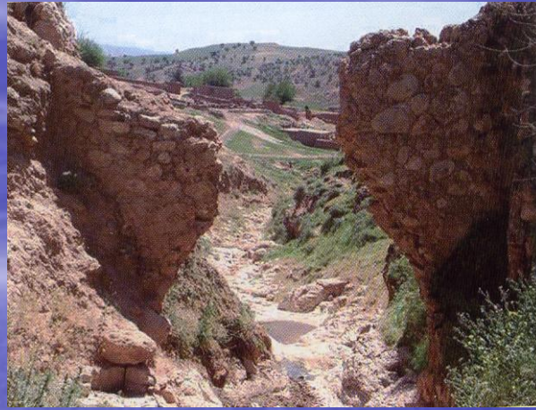
شکل (۶-۹) پل کرو دیت
