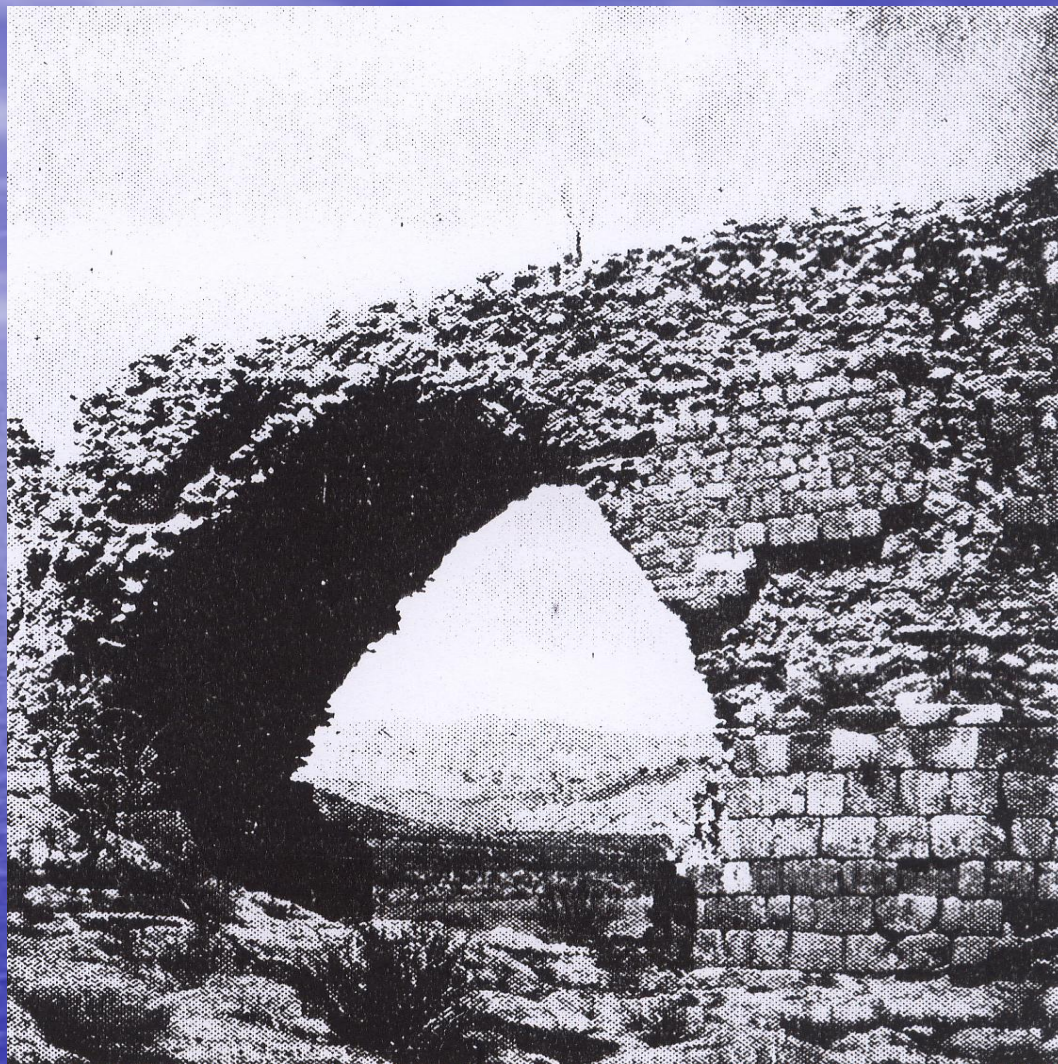
شکل (۶-۱۳) بقایایی از پل هلیلان
