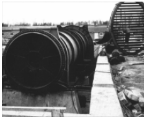
محل نصب پمپ سیرکوله و کارگری که مشغول
