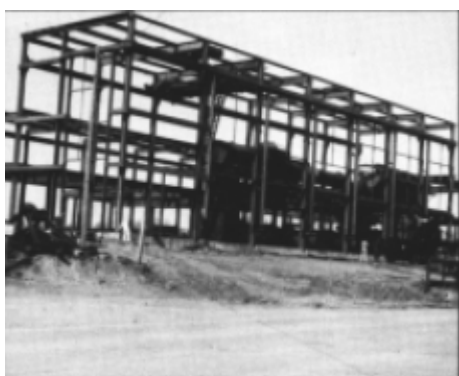
مرحله ساخت ساختمان تونل آب
