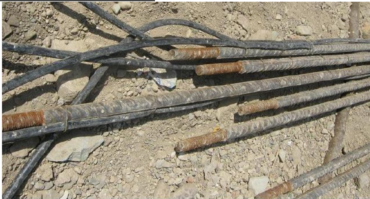
آرماتورهای کششی همراه با لوله های تزریق که اطراف آنها بسته شده است
