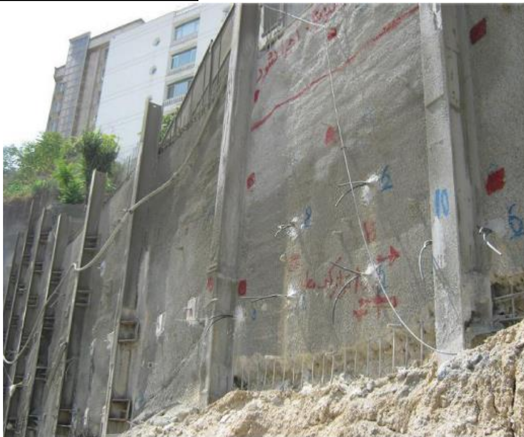
اجرای نیلینگ بر دیواره ورودی پرتال شرقی - کارگاه صدر
